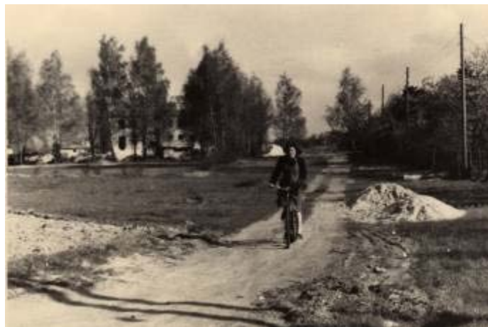
Abb. 7 Menzelstraße, im Hintergrund sieht man die Kaserne
