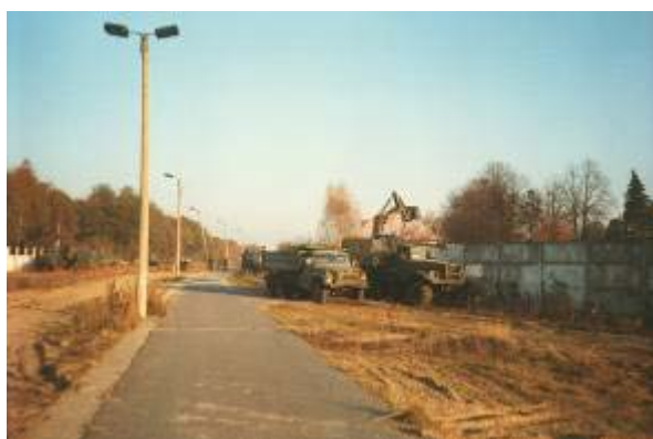
Abb. 16 Rückbau der Grenzanlage
