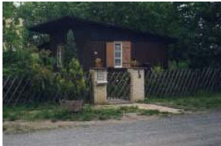
Abb. 6: Behelfsheim in der Wilhelmstraße
